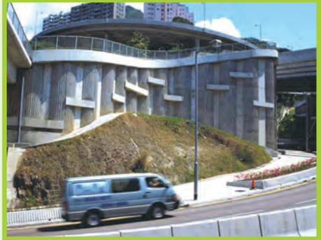
以裝飾性的細條紋和普通混凝土面結合而成的圖案，營造具節奏感與多變化的景色。
