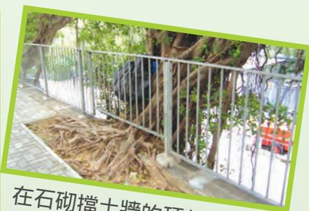
在石砌擋土牆的頂部及底部設種植帶，促進牆上樹木的根部生長。
