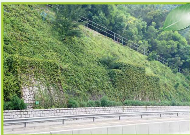
在混凝土擋土牆騰出空間，栽種植物，綠化斜坡。
